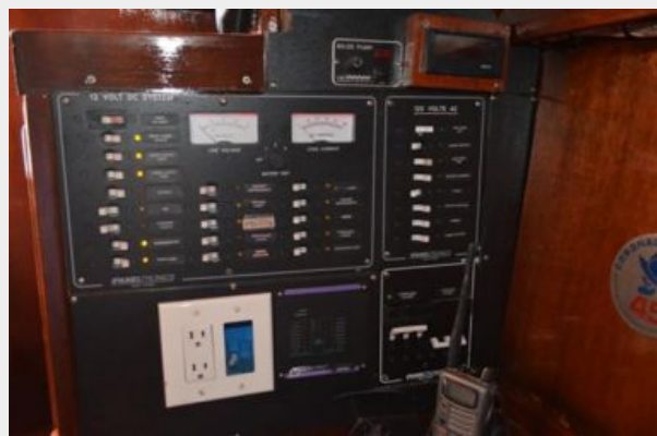
45' Coronado electrical panel
