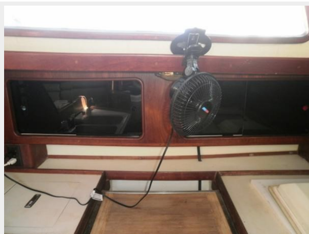
12 Volt fans Forward & Aft
