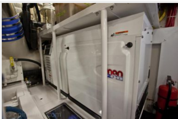
Starboard Onan Generator
