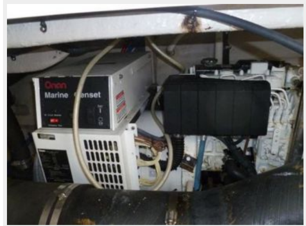
Onan 9KW Generator
