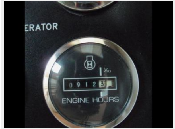
Generator Hour Meter
