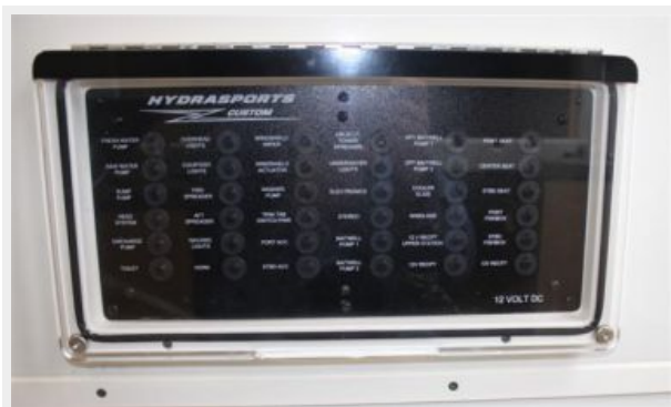
12 Volt Electric Panel
