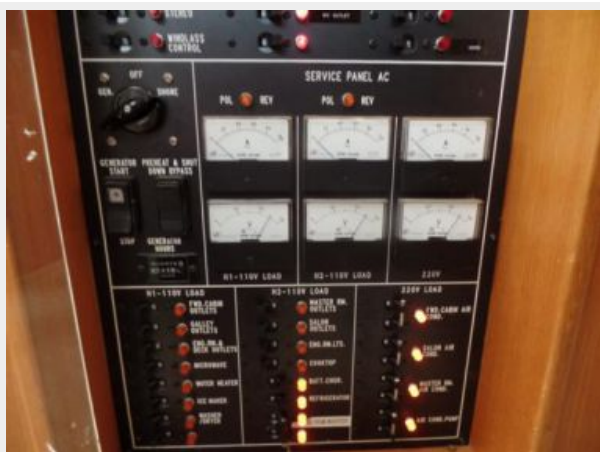
Breaker panel (2).JPG
