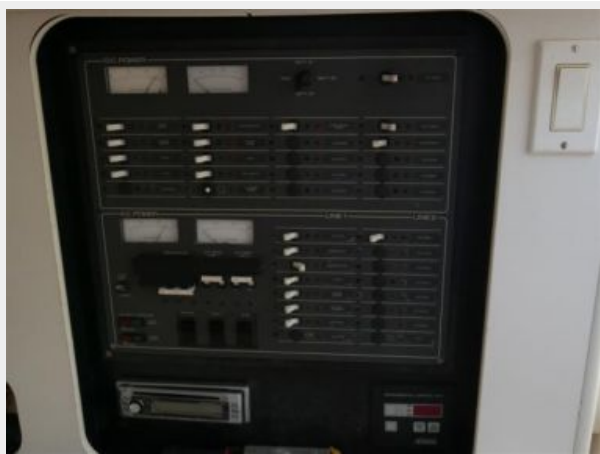
1992 Tiara 31 Coupe - Electrical
