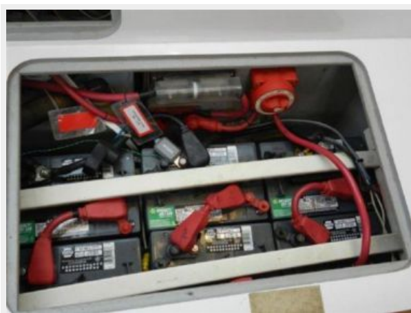
NEW 2018 6 volt batteries
