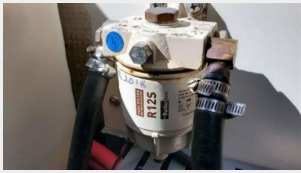
33MECHGeneratorFuelFilter
