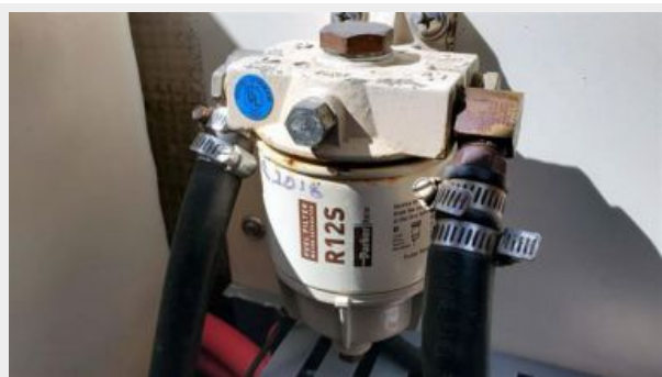
33MECHGeneratorFuelFilter
