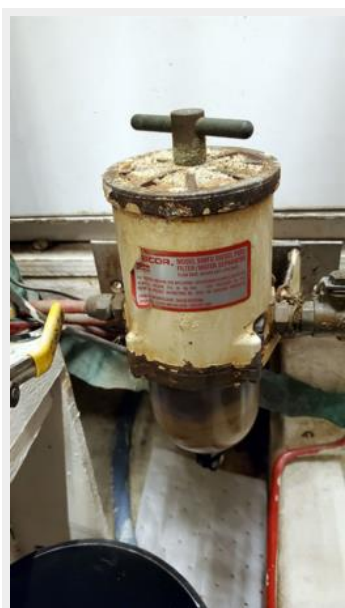
49MECHGeneratorFuelFiltration
