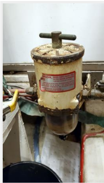
49MECHGeneratorFuelFiltration
