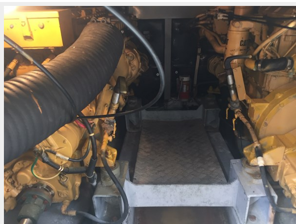
Azimut 36 Fly - Motor Yacht - interior - Motores - IMG_1696
