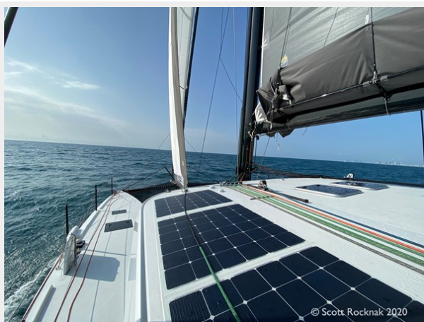
HH50 Solar Array
