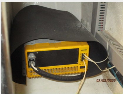
66_2786224_48_camargue_xantrex_inverter
