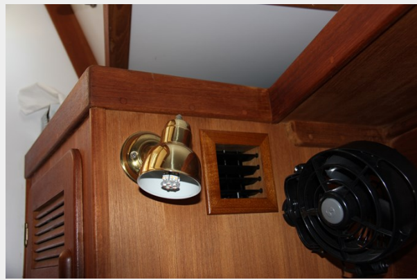
Forward Cabin Air & Fan
