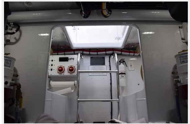
ER Entry Ladder
