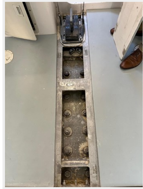
Keel bolts IMG_1858
